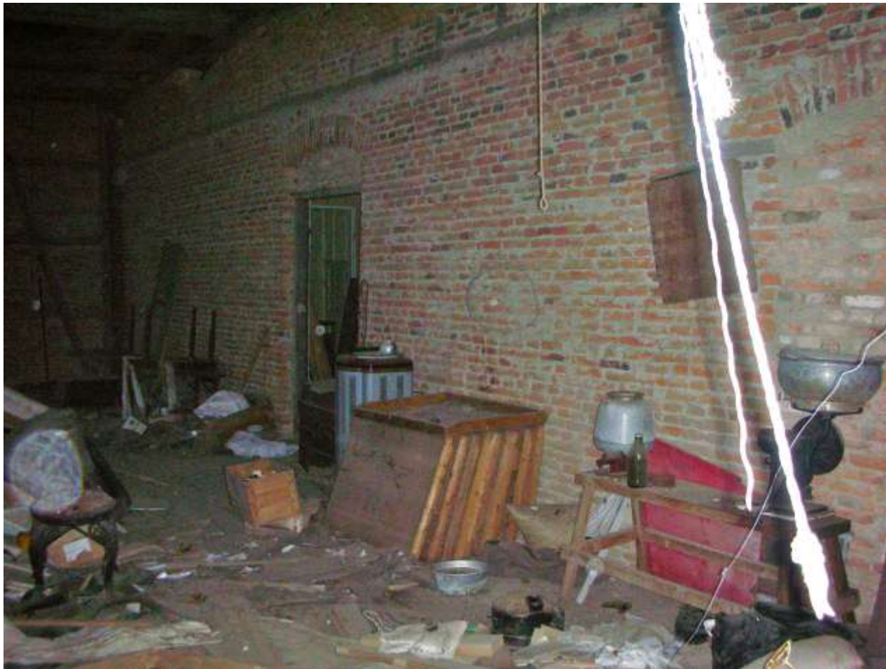
Retning mot trappehallen
