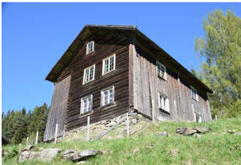
Våningshuset er en svalgangsbbygning fra 1700-tallet og det meste er intakt innendørs.
